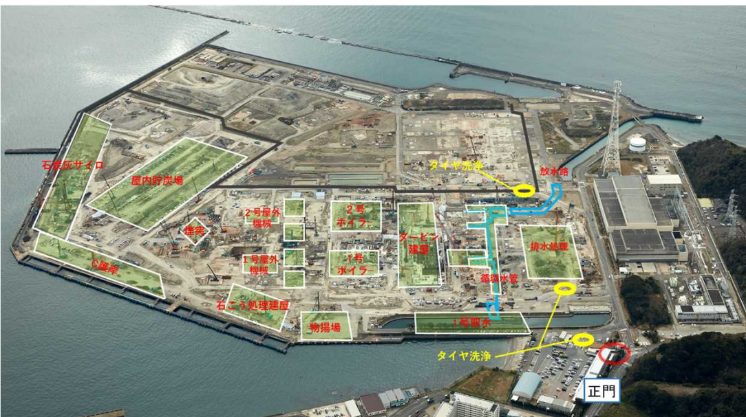
工事の状況 (2020/3時点)
