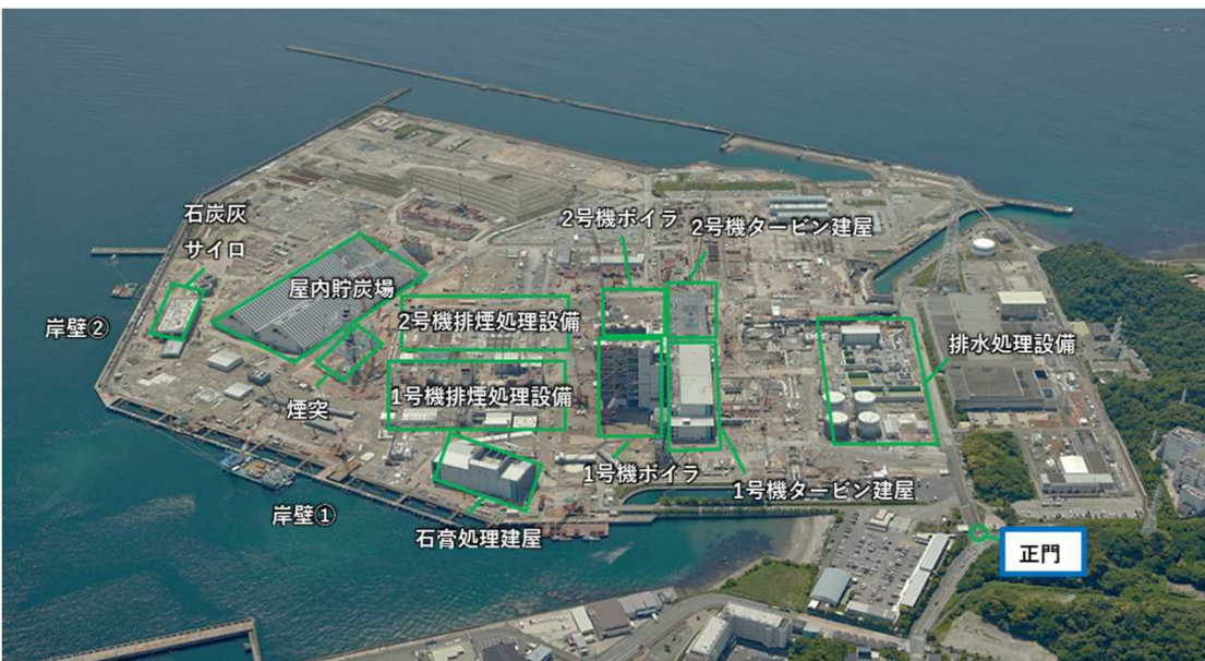
工事の状況（2021/5時点）
