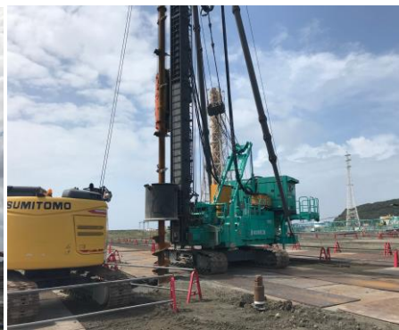
④：貯炭建屋エリア 貯炭建屋を支える杭を地中に埋めています。
