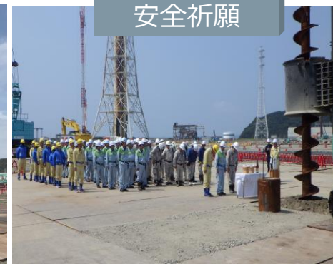
着工にあたり所内の関係者で安全祈願を行いました。
