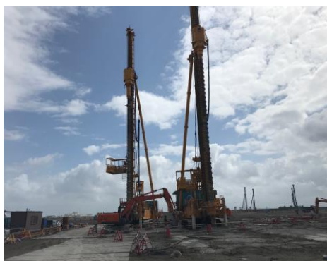
②/③：タービン建屋/ボイラエリア セメント改良材を土と混ぜ合わせることで、地面の強度を高めます。
