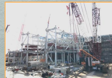
1号ボイラ 1号のボイラの鉄骨建方工事を開始しました。
