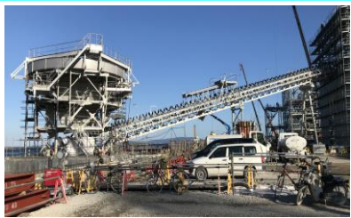
石炭コンベア 船から受け入れた石炭を屋内貯炭場へ運搬するコンベアの据付を開始しました。
