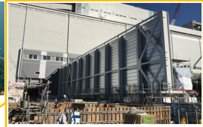
防音設備 発電に伴う構外への音を最小限とするために防音壁などを設置しています。
