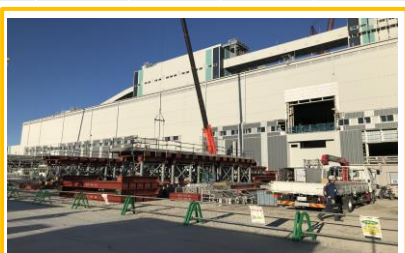
2号タービン搬入準備 タービンを建物内に搬入するための仮設備を準備しています。
