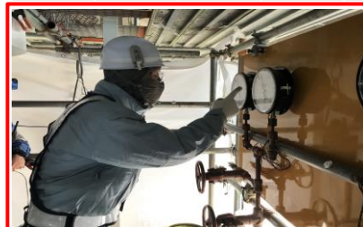
1号ボイラー水圧試験 国の安全基準に則り、ボイラーの配管に水圧をかけて漏れない事を確認しています。
