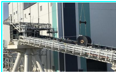
石炭コンベア 石炭をボイラーへ搬送するコンベアのベルト取付作業をしています。
