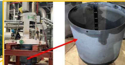
タービン入口の蒸気弁
