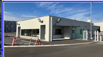
新警備室について 発電設備を警備する要員の詰所を新設しました。A地点からB地点に移転します。
