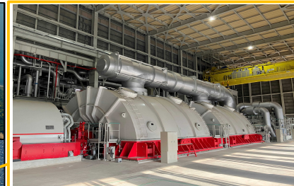
2号機 性能試験前点検 所定の効率や環境性を確認する性能試験の前にボイラやタービン発電機を停止して点検をしています。
