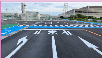
道路標示の整備 構内の交通安全確保のため、道路標示の整備を進めています。
